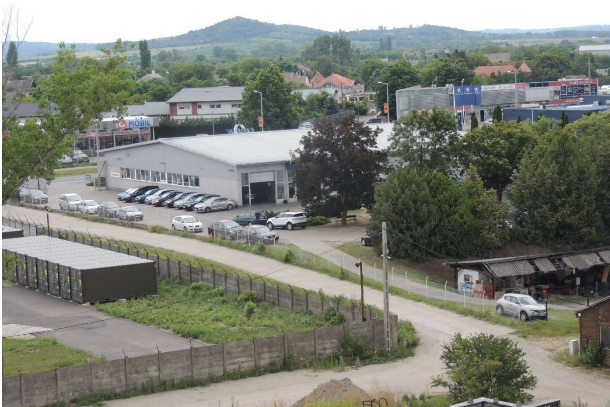
7. ábra: A telep megközelítését várhatóan biztosító 4552/12 hrsz-ú út és a kép jobb oldalán lévő bontandó faszervezetű épület
